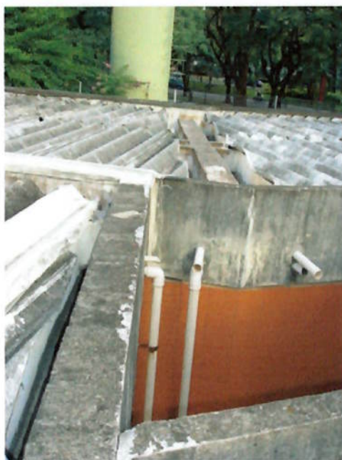
Fig. 22 - Tubos de descida - Módulo 1 e administração (drenagem da água da chuva).
